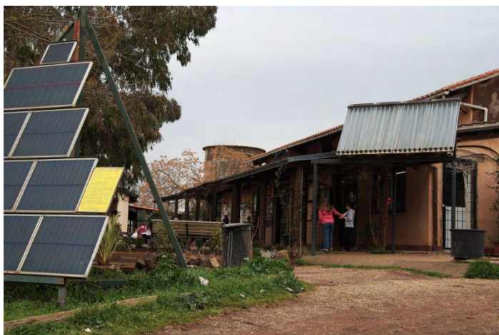
Les panneaux solaires et pour le réchauffement de l'eau
